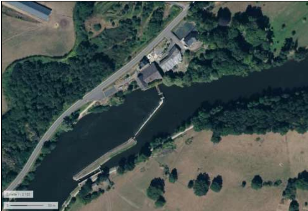
Figure 3 : Barrage de Belle Poule (source : Géoportail)
