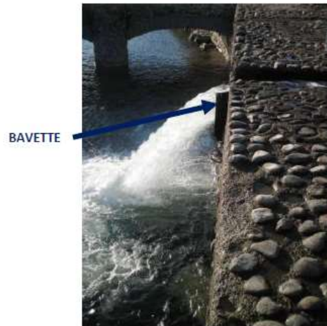
Figure 57 : Exemple de bavette en exutoire (source OFB)
