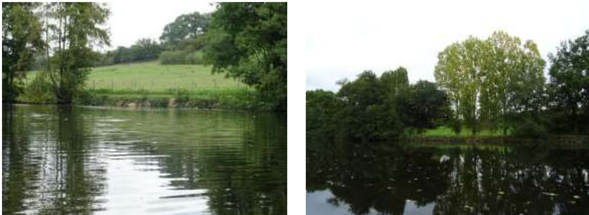
Figure 29 : Illustrations des protections en enrochement en rive gauche
